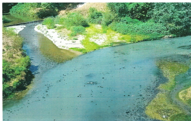
Φώτο 2 Γέφυρα Πολυπλατάνου Νάουσας 09/08/24
