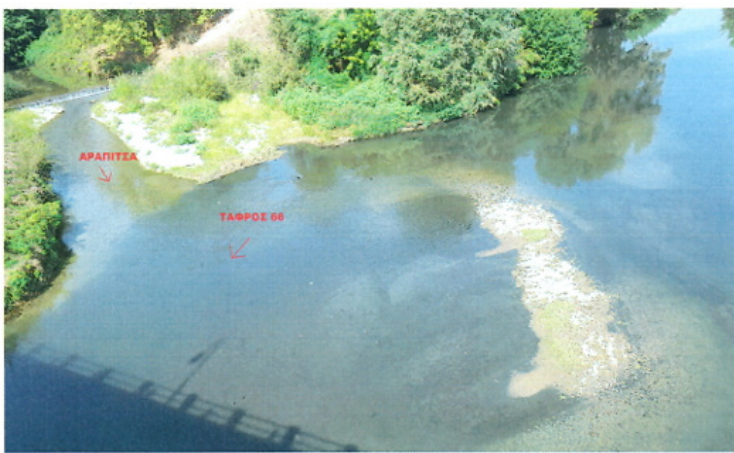
Φώτο 1 Γέφυρα Πολυπλατάνου Νάουσας 25/08/24
